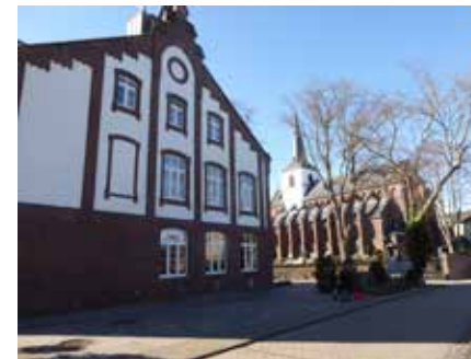
Das markante Gebäude des Mercator-Hotels, mit der Pfarrkirche im Hintergrund
